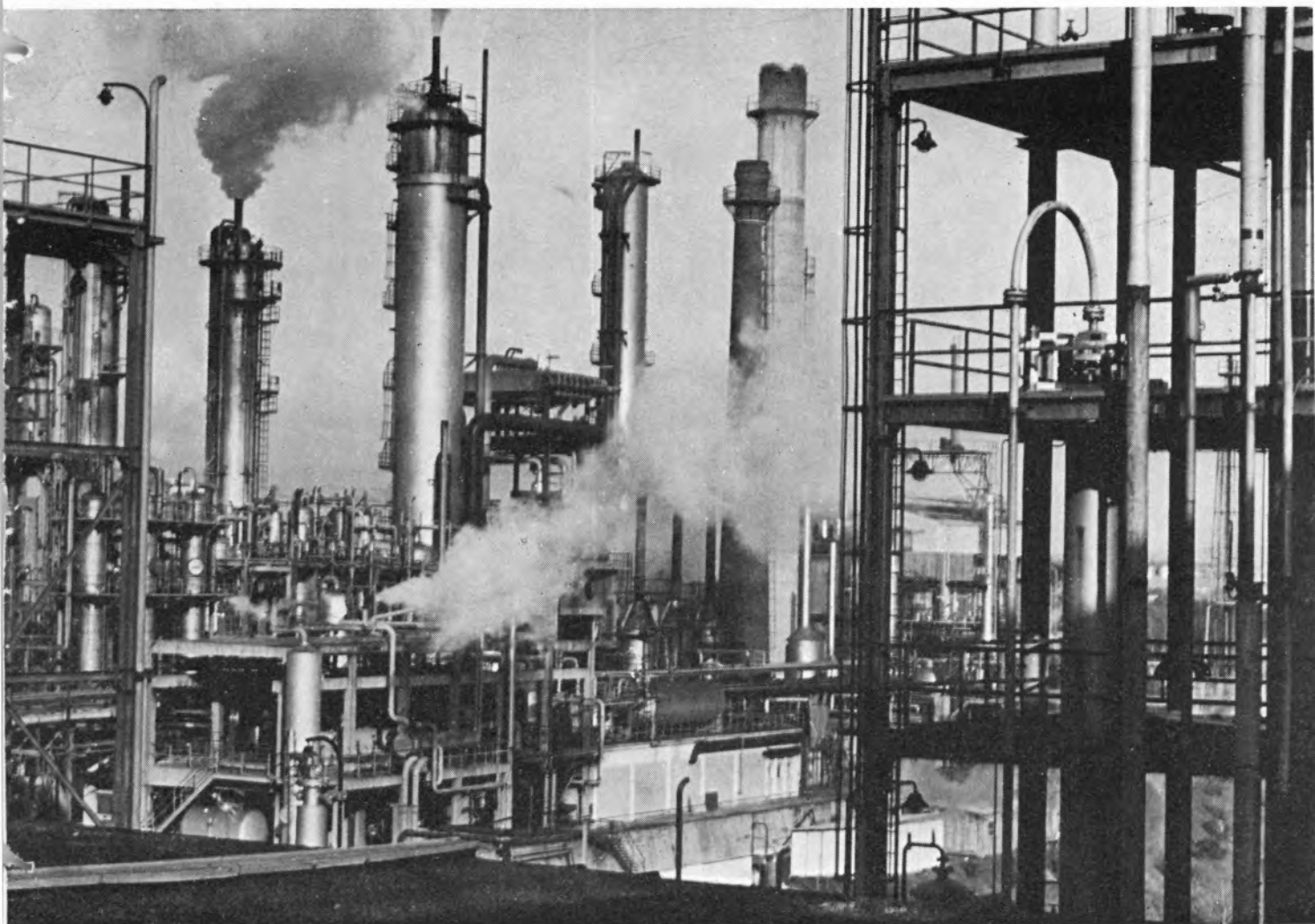
Vista das instalações fabris da Sociedade Portuguesa de Petroquímica
